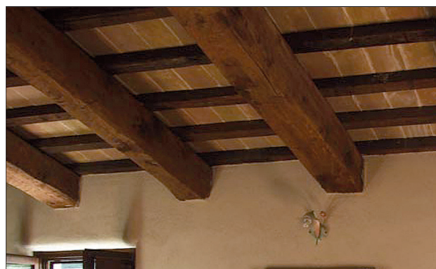
Solaio in legno con mezzana
