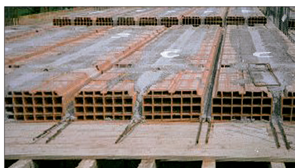
Solaio in laterocemento gettato in opera.
