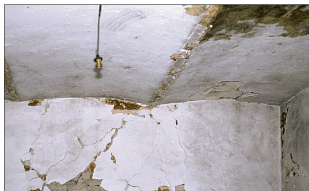
Solaio con travi di ferro a voltine.
