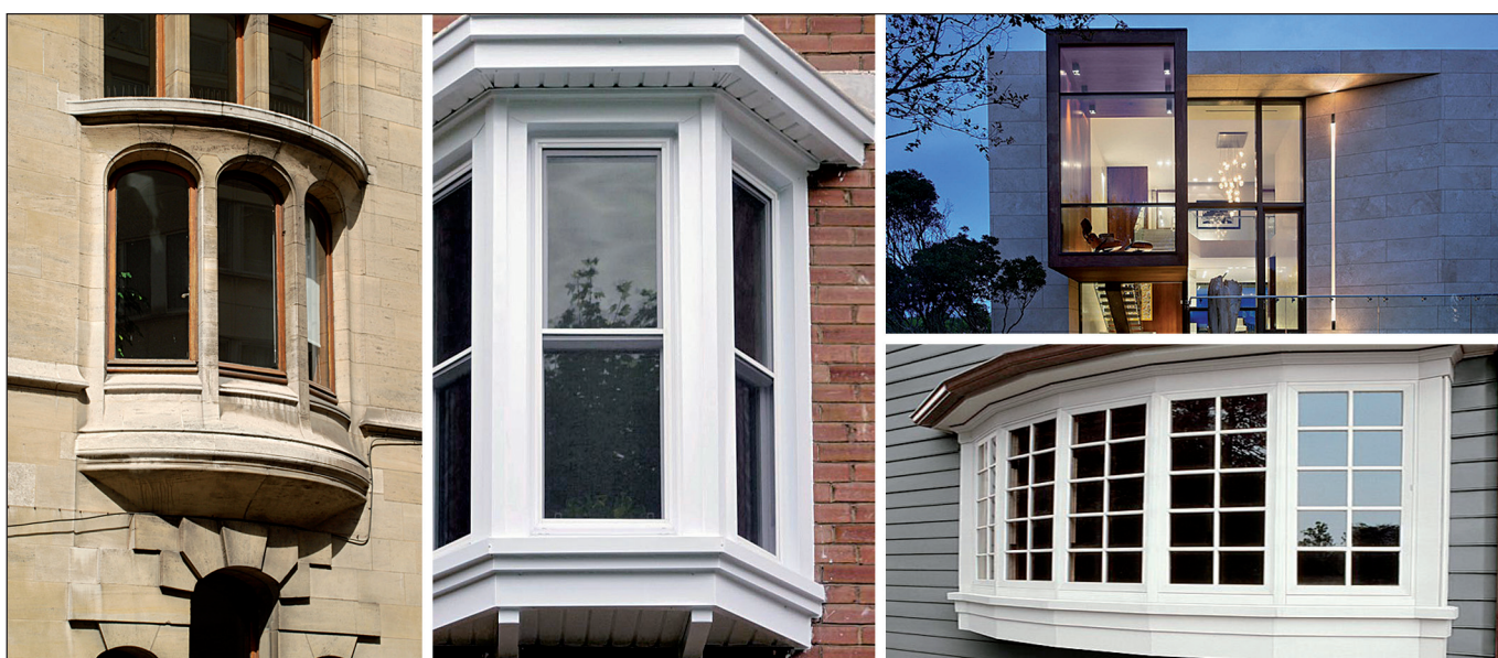
Figura 8. Esempi di bow windows.
