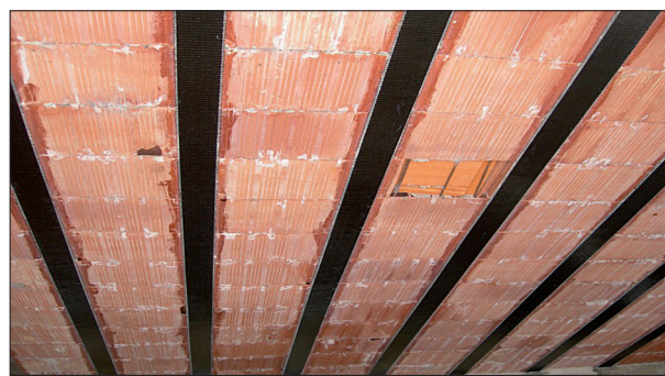
Solaio in ferro e tavelloni.
