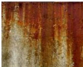
**Macchia di ruggine** – cause: errore di progettazione, errore di posa, evento accidentale, invecchiamento naturale
