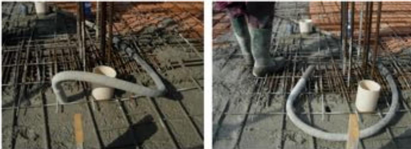
**Costipamento dell'impasto nella cassaforma tramite vibratura**
