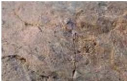
**Fratturazione o fessurazione** – cause: errore di progettazione, errore di posa, causa accidentale
