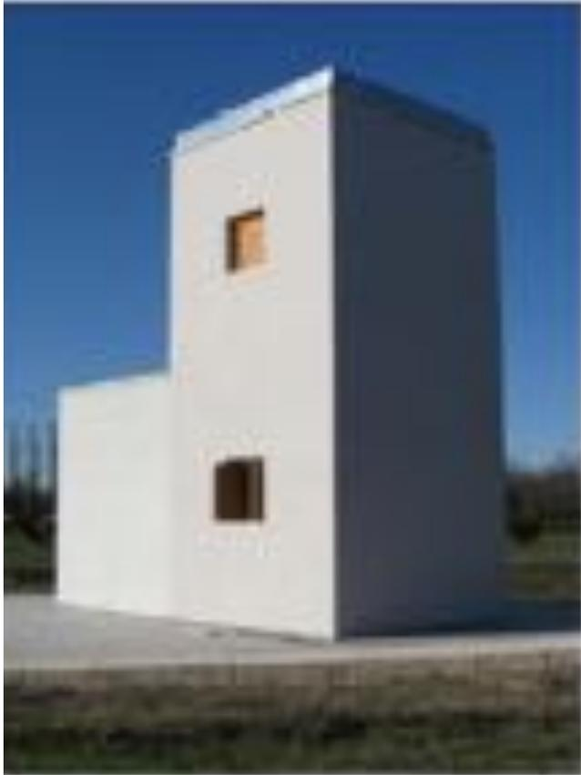
Edificio in scala 1:1. composto da due locali a PT e un altro al 2°P. per disporre di una parete esterna ventilata di 6 metri di altezza.
