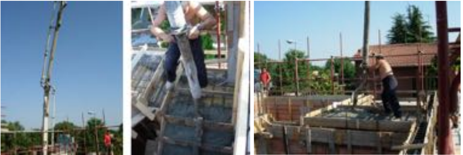
Getto dell'impasto tramite pompa per cls
