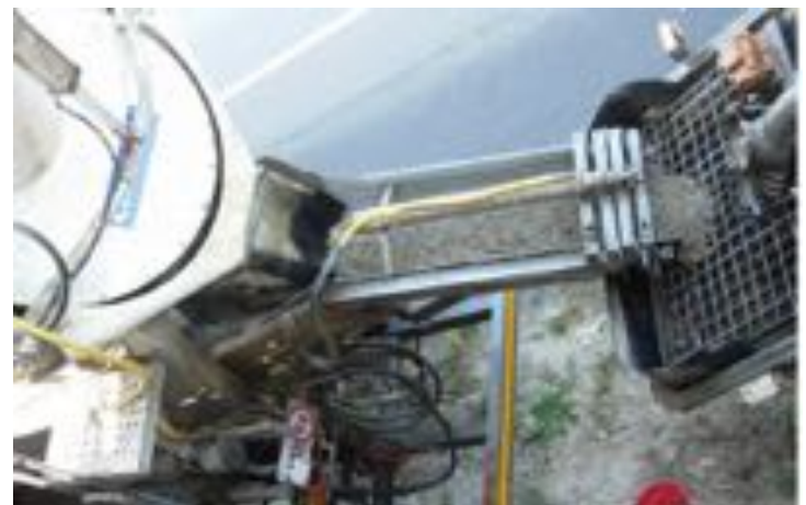
Trasporto tramite autobetoniera
