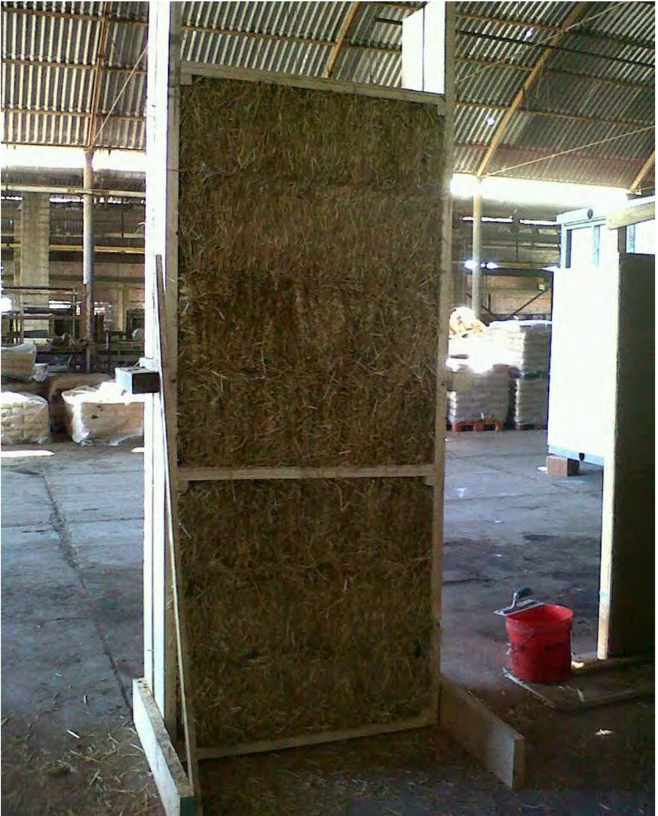
*Fig. 6 – Dettaglio del telaio in legno con le balle di paglia*
