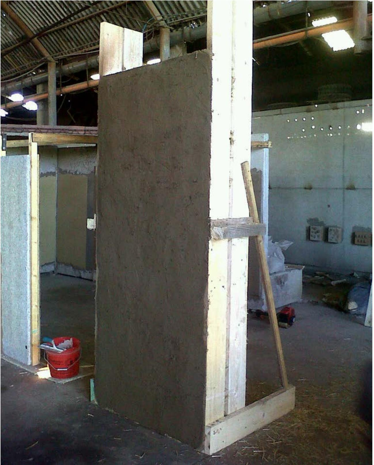
*Fig. 7 – Dettaglio del telaio in legno con le balle di paglia intonacate*
