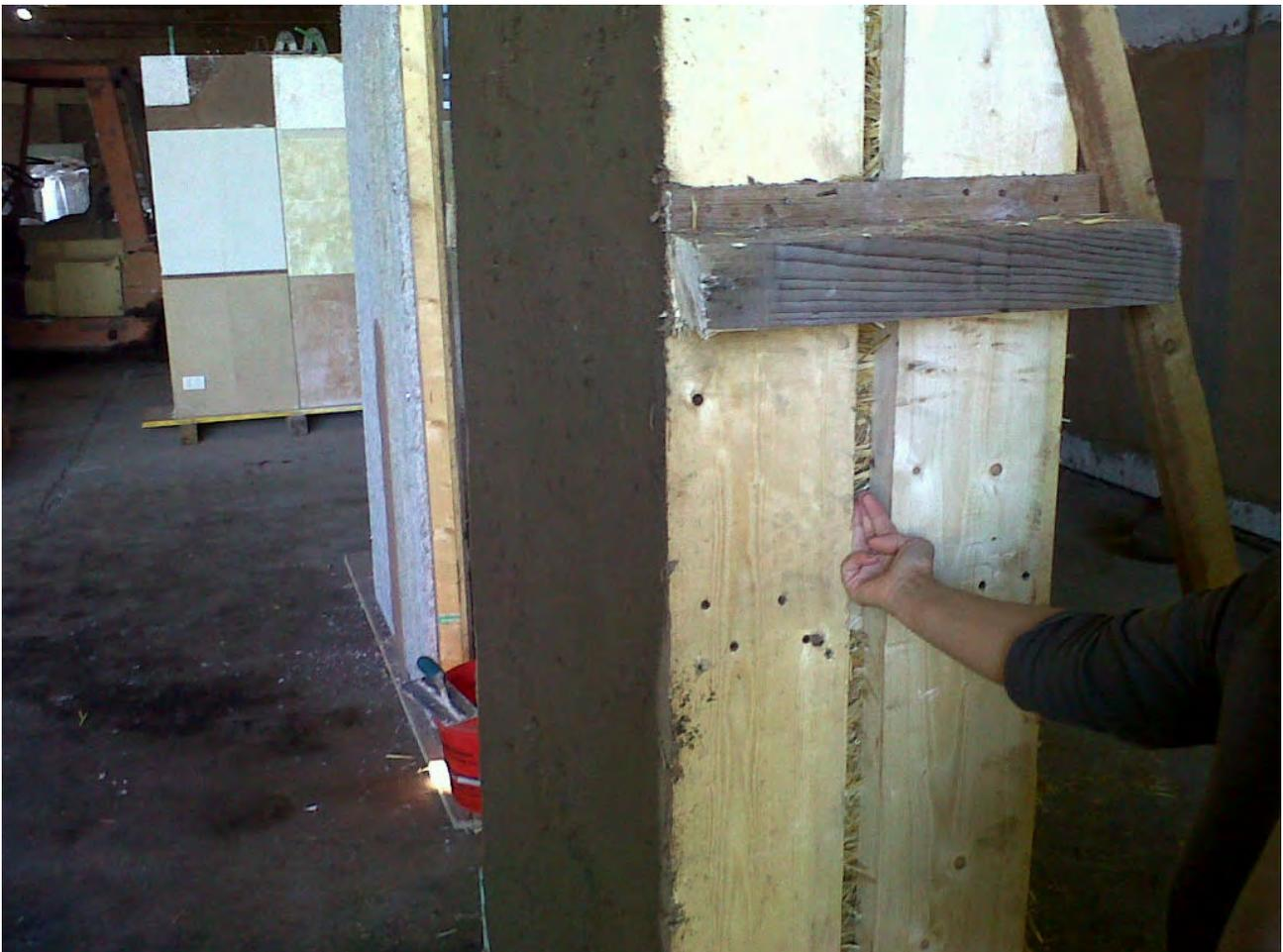
*Fig. 5 – Dettaglio del telaio in legno con le balle di paglia intonacate*
